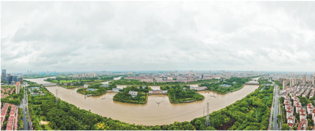
图为江苏省扬州市江都区的南水北调东线源头江都水利枢纽(无人机全景照片)。新华社发(孟德龙摄)
