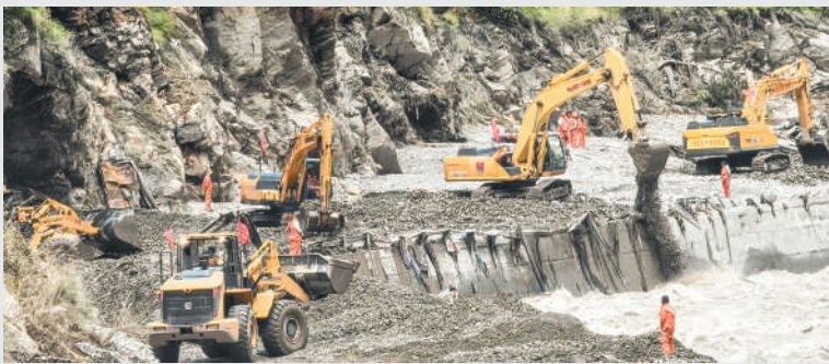
8月27日,救援车辆在为通往灾区的道路清淤。吉隆泥石流灾害发生后,西藏自治区迅速组织力量对通往吉隆口岸的G216线受灾路段开展抢险保通作业。截至8月27日18时,受灾路段已抢通800米左右。
