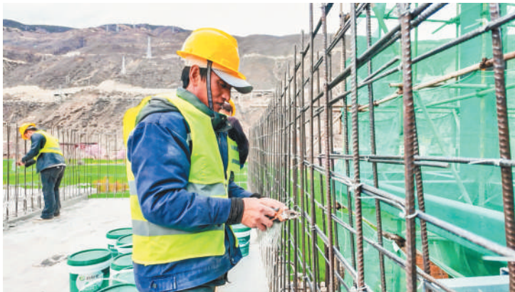
嘻唻口袋公园建设现场。李颖 摄
