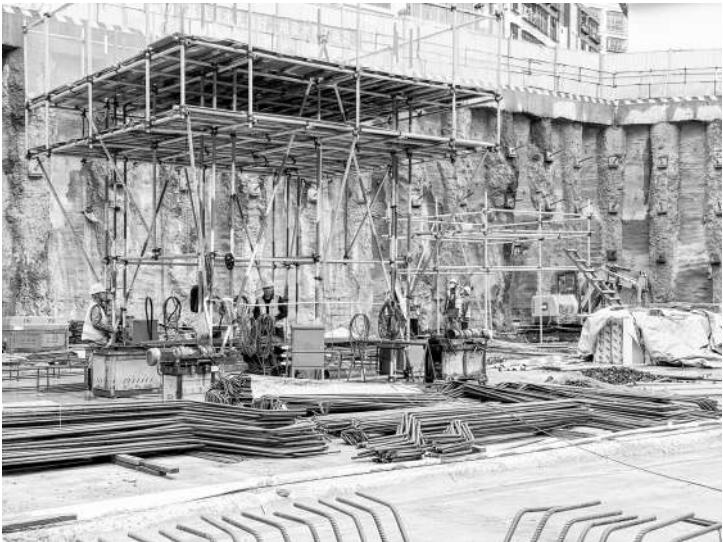
建设施工现场。
