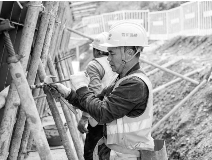
建筑工人奋战在工地一线。
