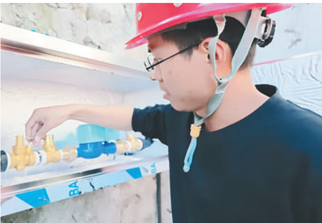
施工人员正在加紧布设供水管线。
